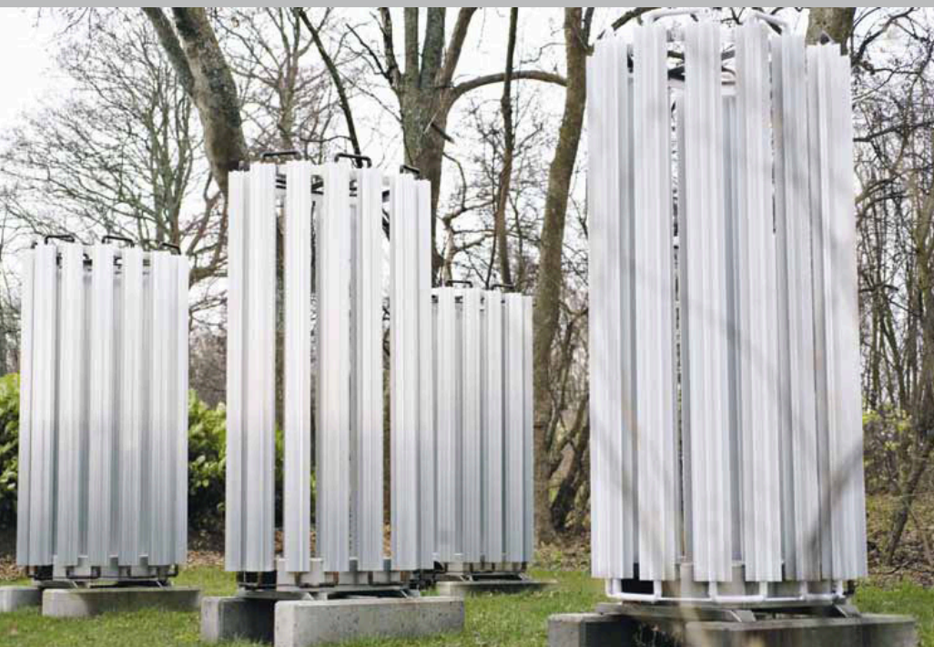
VARME FRA UDELUFT. Ispindene sørger for, at der konstant er 22 grader overalt inden døre på godset Strandegaard. Ivan Reedtz-Thott er i øjeblikket ved at etablere Danmarks største udendørs svømmebassin i forbindelse med godsets campingplads. 'Vi overvejer at varme det op med ispinde', siger han. – Foto: Hanne Loop.
